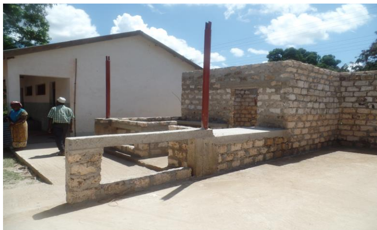
Nieuwe keuken in aanbouw
